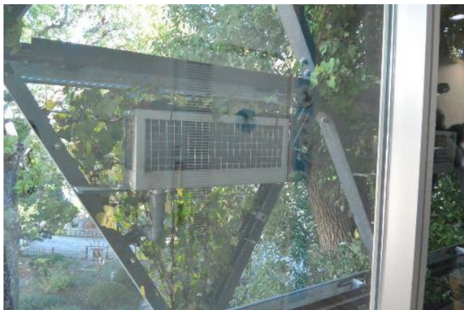
写真 1-5 外壁を覆うツタの漏水装置
