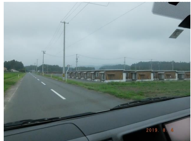
南相馬市鹿島区内の仮設住宅。入居者は自ら土地を求めたり、集団移転などによりほとんどの方が退去している。年内には取り壊される予定
