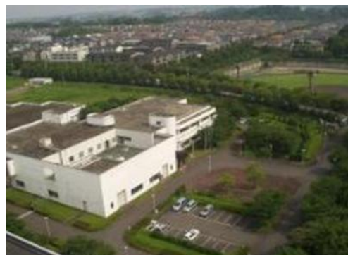
鶴見川クリーンセンターを俯瞰する
