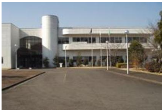
鶴見川クリーンセンター正面玄関
